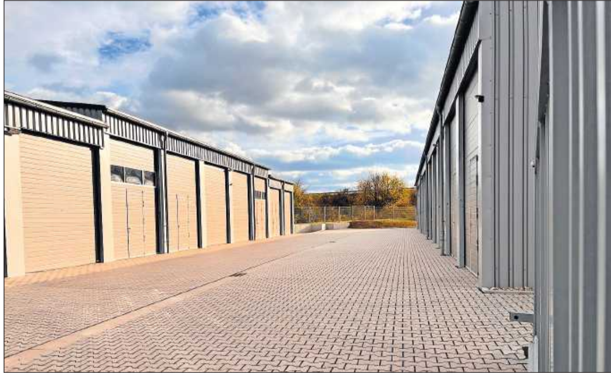
2021 fertiggestellt: der erste Garagenpark in der Von-Ketteler-Straße.
