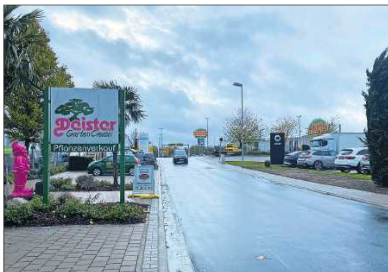
Sanierung beendet: Auf den letzten Metern vor der Globus-Zufahrt war die Grünstadter Ferdinand-Porsche-Straße abgesackt. FOTO: CHRISTOPH HÄMMELMANN
